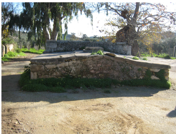
ΔΥΤΙΚΗ ΟΨΗ ΤΗΣ ΒΡΥΣΗΣ
