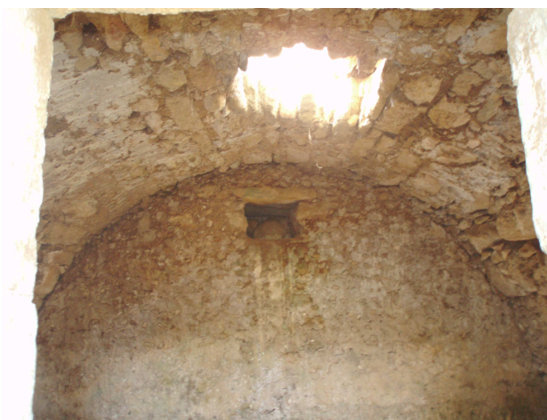
ΕΣΩΤΕΡΙΚΗ ΟΨΗ ΟΡΟΦΗΣ ΒΡΥΣΗΣ
